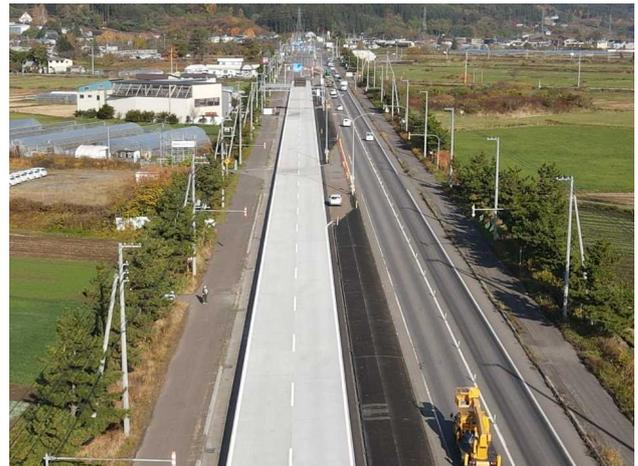
写真-3 Co舗装工完了時 (R3.11撮影)
