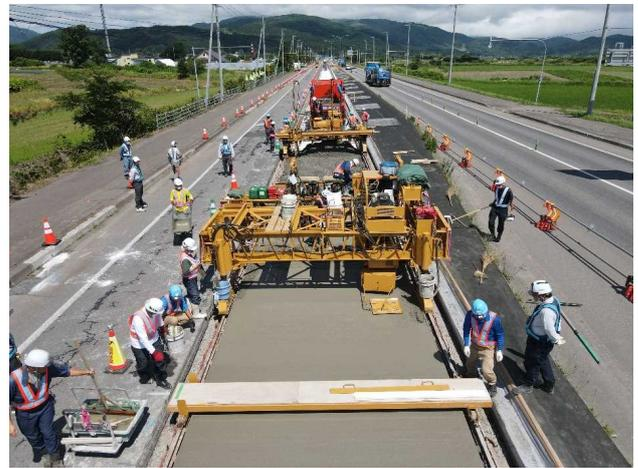
写真-2 Co舗装施工状況 (R3.7撮影)
