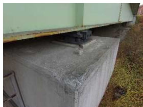
外桁支承確認写真
