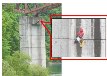
図-3 クライミング点検による高橋脚での作業状況
