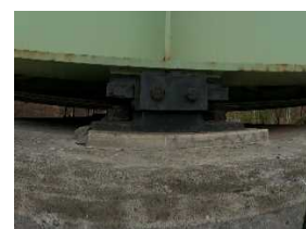
支承確認写真
