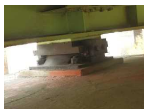
支承確認写真
