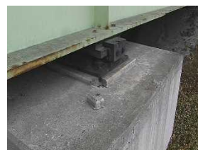
外桁支承確認写真
