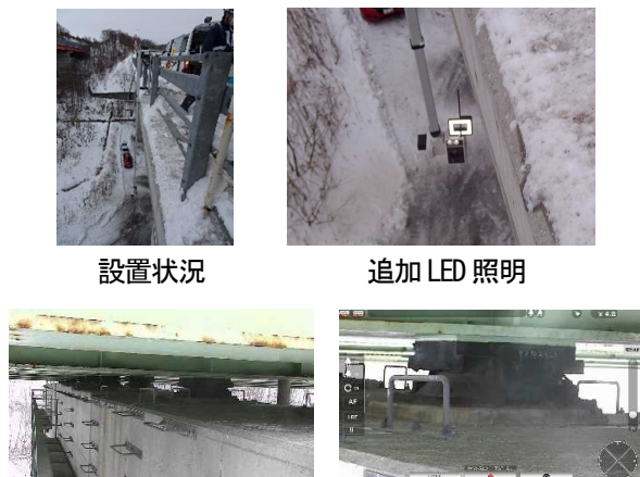
図-13 ロボットカメラ作業状況
