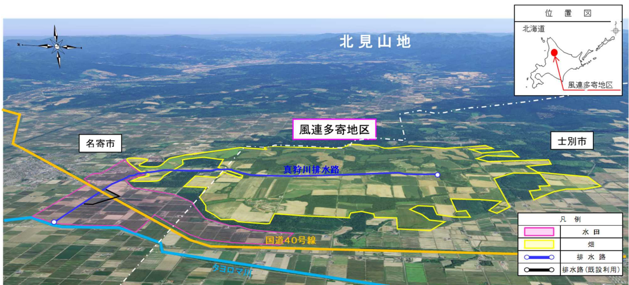
図-1 風連多寄地区周辺の状況
