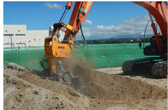
写真-2 固化処理材の攪拌様子
