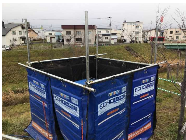
写真-2 発電機に防音シートを設置
