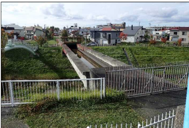
図-2 利根別水路橋（既設）
