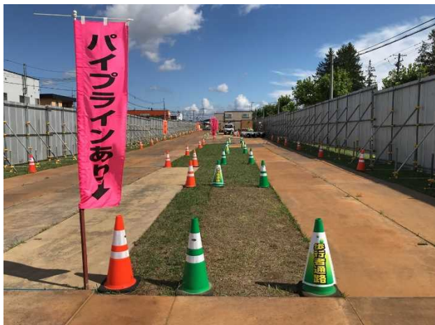
写真-1 安全鋼板の設置
