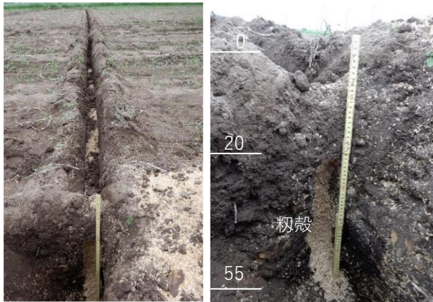
図-2 有材心土破碎の状況写真
