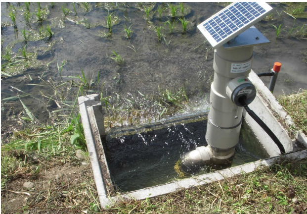
写真-4 水管理システム設置状況
