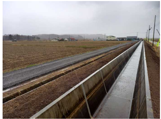
写真-4 V型トラフ復旧状況
