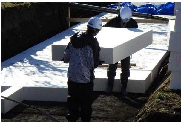
写真-3 EPSブロック運搬・据付状況
