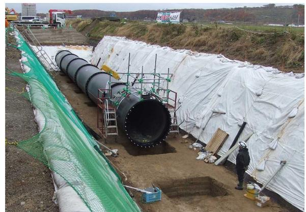
写真-2 継手堀の施工状況 (口径 2000mm)
