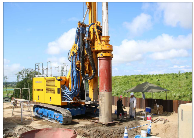
写真-7 BG工法施工状況
