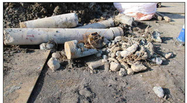
写真-8 撤去した基礎杭（先端継手金物）
