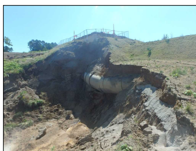
写真-2 管水路状況 (図-4の②)
