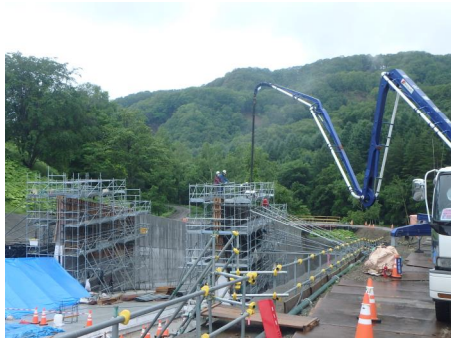
写真-5 コンクリート打設状況
