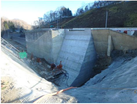
写真-7 A2橋台の完成状況
