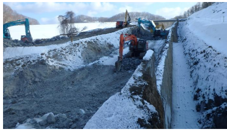
写真-4 洪水吐撤去状況
