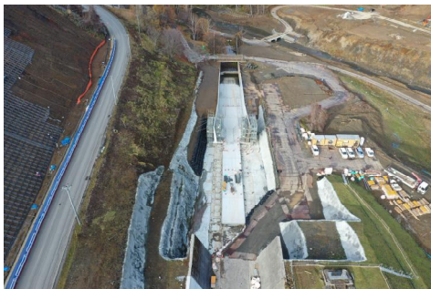
写真-6 現在の洪水吐 (令和3年11月撮影)
