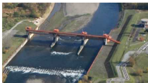
図-1 大雪頭首工の全景
