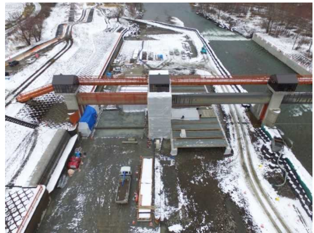
図-5 第4期工事の河川内仮締切の様子
