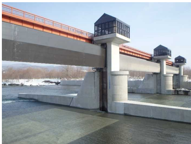
図-6 ゲートの施工後写真
