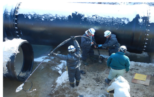
図-12 層別沈下計の設置の様子
