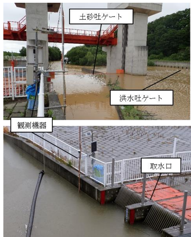
図-2 頭首工地点の観測状況
