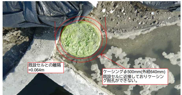
図-8 既設鋼管杭(ケーシング削孔不可)
