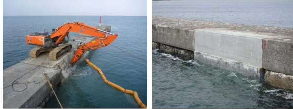
c) 断面の一部切削とコンクリート充填による補修事例
