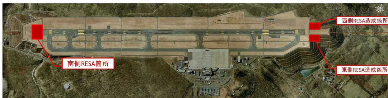
写真-1 釧路空港RESA造成箇所
