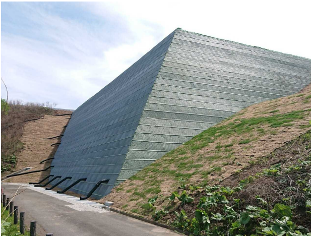
写真-5 東側滑走路端安全区域完成状況
