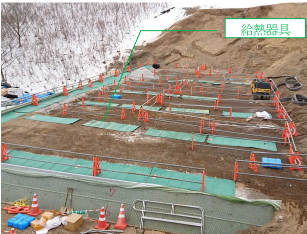
写真-2 給熱養生状況
