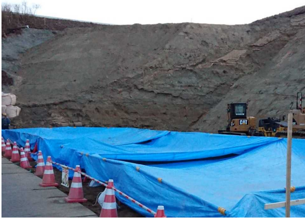
写真-3 寒風対策状況
