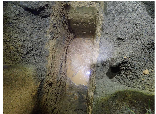
写真-4 湧水確認状況
