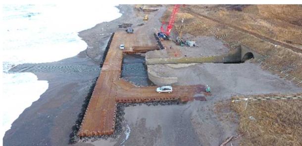
写真-2 海岸仮締切工設置後
