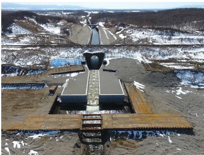
写真-9 施工状況
