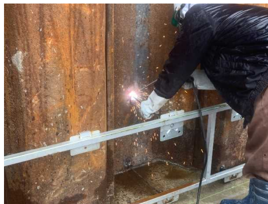
写真-8 枠型定規設置状況
