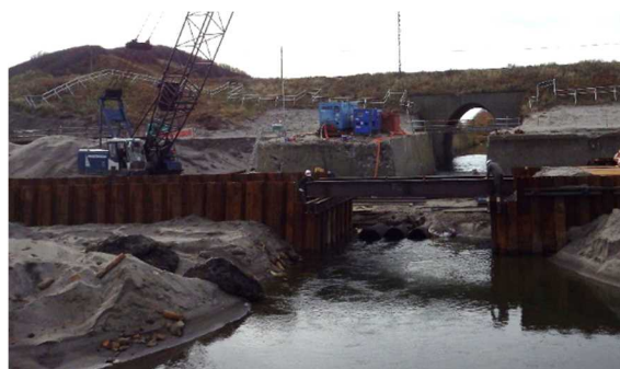
写真-3 仮排水管設置状況
