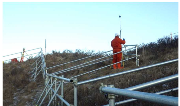
写真-6 軌道線変位観測状況
