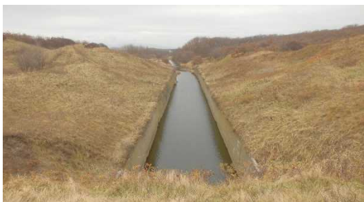
写真-7 鋼矢板護岸工設置前
