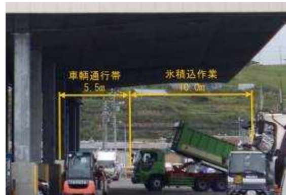
写真-4 氷積込状況
