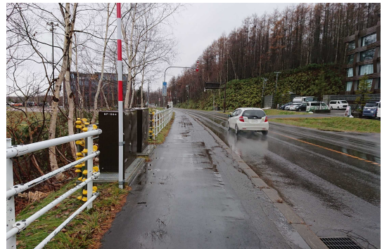
写真-4 歩道外に設置し安全性やメンテナンス性が向上
