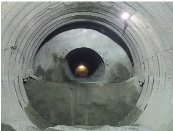
写真-6 中央導坑先進工法による本坑拡幅掘削
