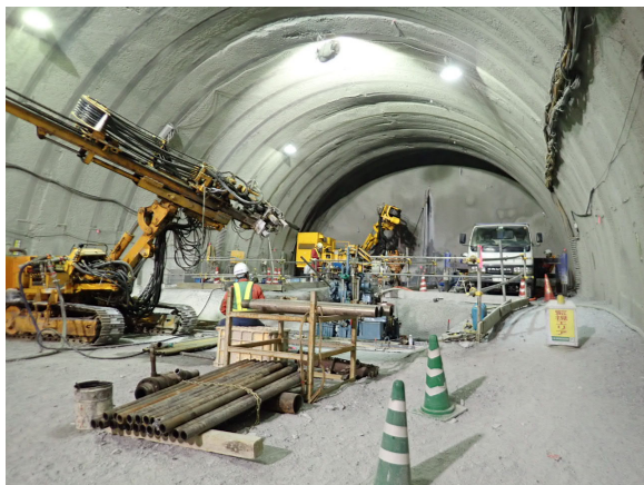
写真-3 調査ボーリング実施状況
