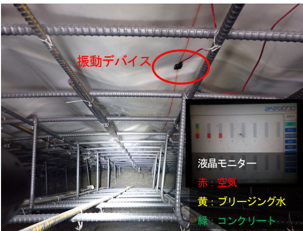
写真-10 覆工充填確認状況
