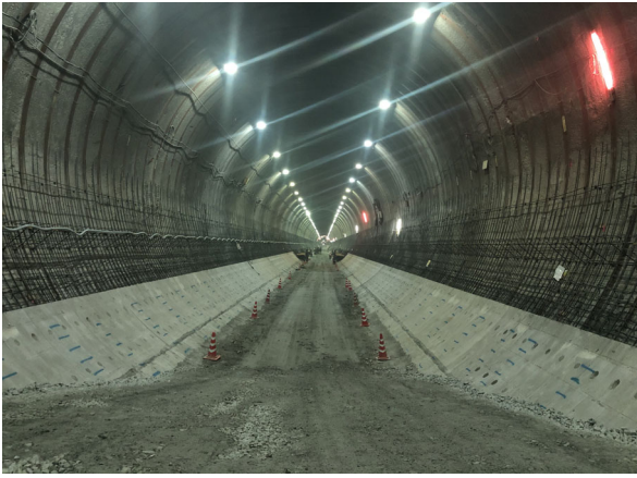
写真-9 埋設型枠によるインバート施工状況
