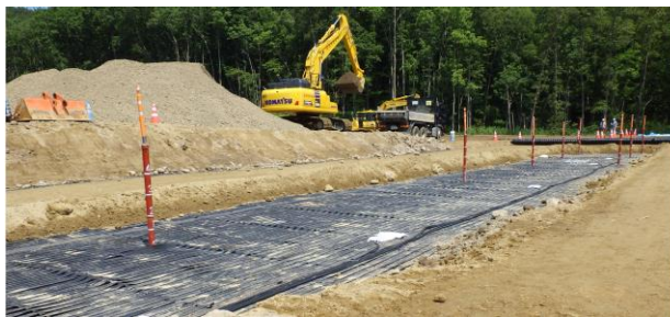
写真-3 ジオシンセティックス(上面)の敷設状況
