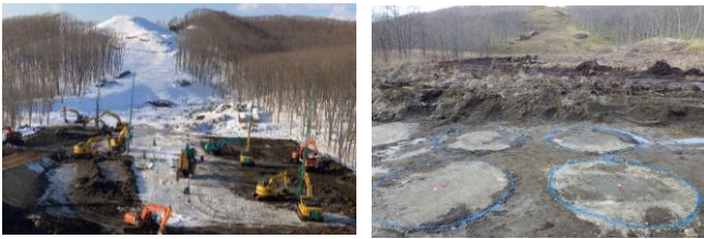
写真-1 地盤改良施工状況(左)と施工後の改良柱体(右)
