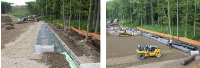
写真-2 のり尻ふとん簞(左)と中詰材の施工状況(右)
