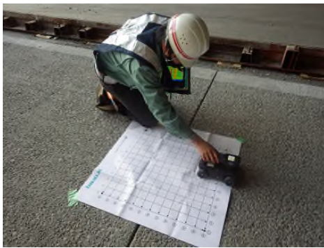
写真-10 電磁波レーダによる測定状況
