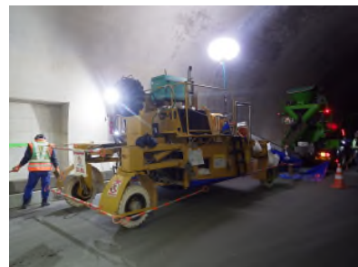
写真-4 縁石工の機械編成（本工事）
