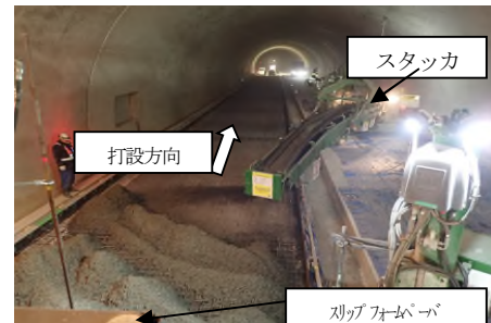
写真-8 スタッカによる敷均し状況
