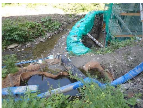
写真 4 ヤシガラマットを用いた濁水対策実施状況 (写真 1 の下流部)
