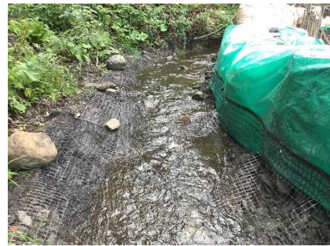
写真 8 産卵防止ネット設置状況
