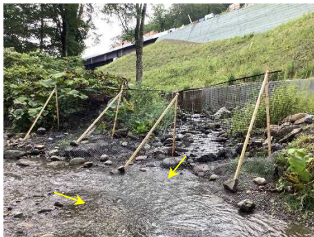
写真 7 遡上防止ネット設置状況
