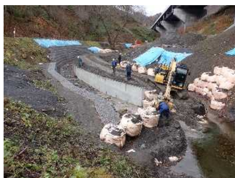
写真10 河川切替実施状況
