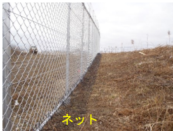
写真-21 侵入防止柵とネット
