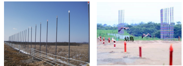
写真-5 工事区域内のポール式模型（左 H22, 右 H24）
