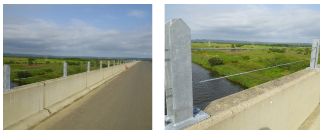
写真-18 本設置された防鳥ワイヤー
