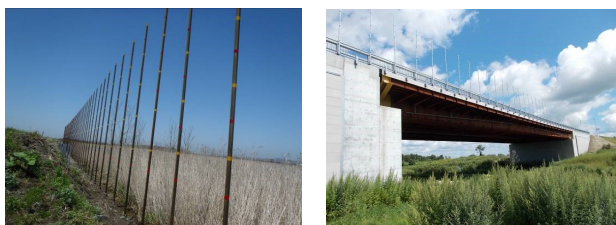
写真-6 ポール式模型 1.5m間隔と本設置ポール2m間隔
