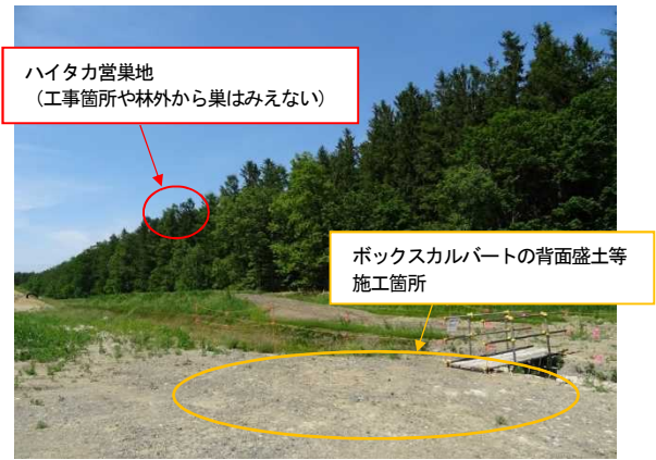
写真8 ハイタカ営巣林と工事業箇所
