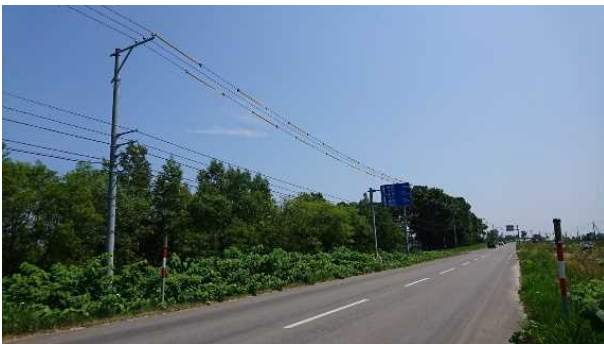
写真 11 電線への衝突防止管設置状況
