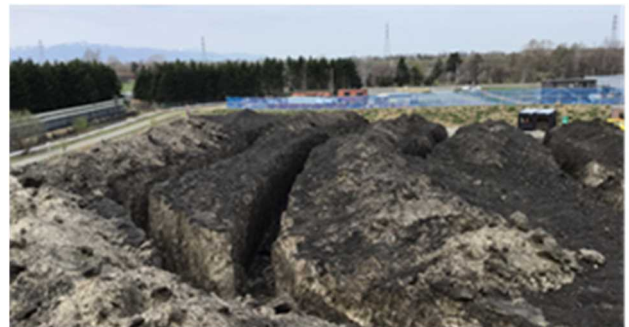
図-8 溝の切削後の状況
