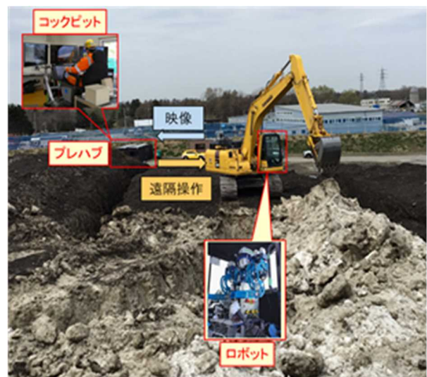
図-5 第2回遠隔操作試験状況
