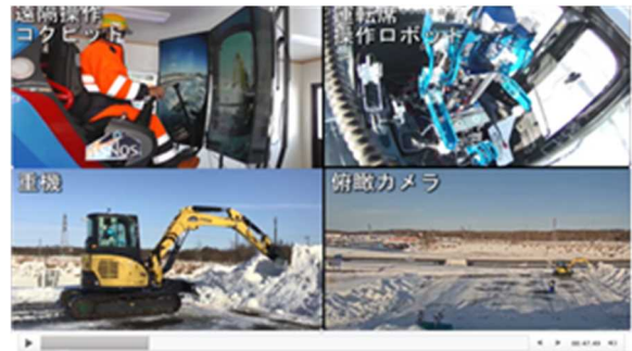
図-4 第1回試験での除雪車の走行・操作イメージ
