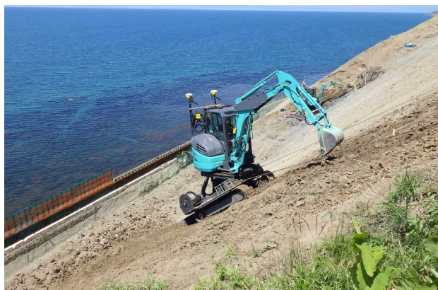
※ICT施工状況
