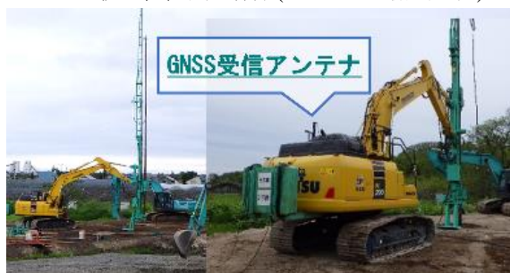
図-6 ICT 施工状況(MITS 工法協会提供)
