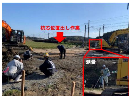
図-5 杭芯位置出し作業(MITS 工法協会提供)
