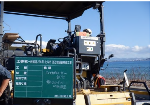
[電気スクリード加熱装置]
