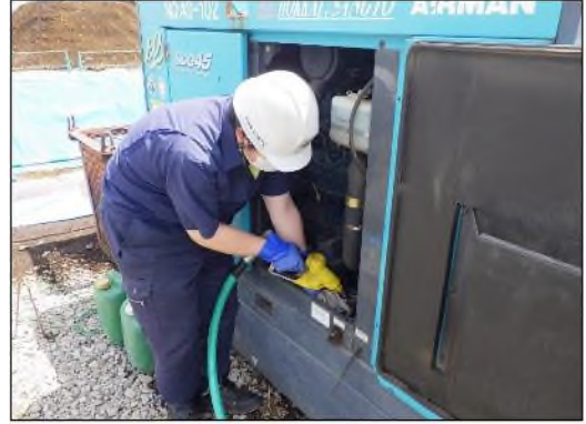
[建設機械への給油状況]
