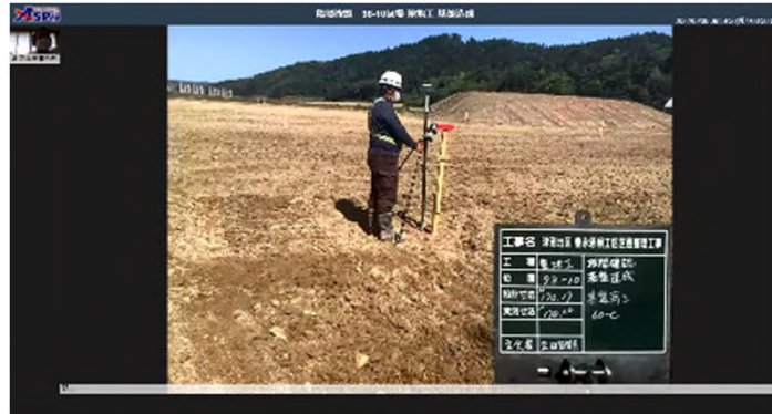
[北見農業事務所内での遠隔臨場による現地確認画面]
