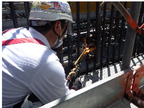
[天然ガスを用いたガス圧接工法の使用]
