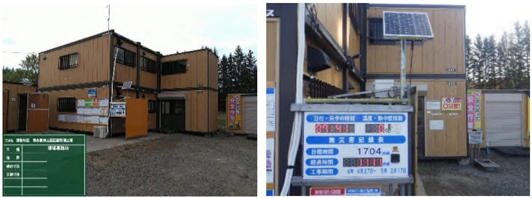
[ソーラー式マルチデジタルパネルの設置状況]
