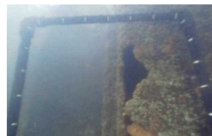
鋼矢板の開孔事例
