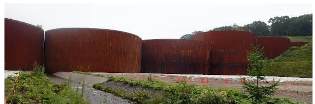
図4 熊の沢川2号砂防堰堤
