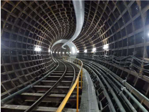
写真－7 鋼製セグメント施工状況
