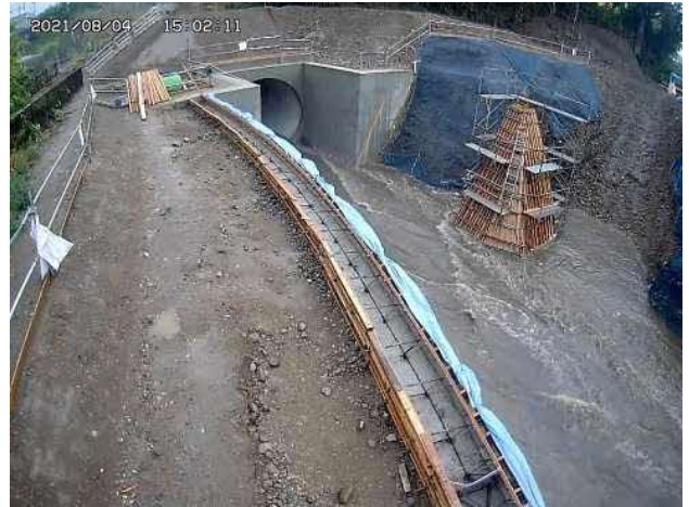
写真－9 吐口通水状況
