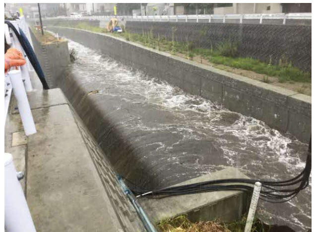
写真－10 呑口通水状況
