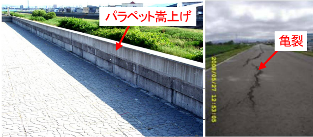
写真-1 特殊堤補修
