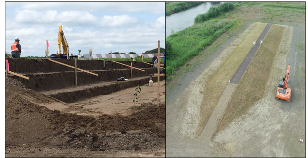
写真-2 左：造成時の様子 右：試験堤防の空撮
