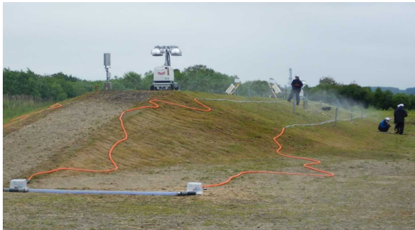
写真-3 散水の様子
