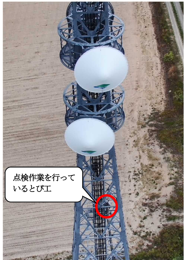
写真-3 多寄無線中継所の鉄塔
