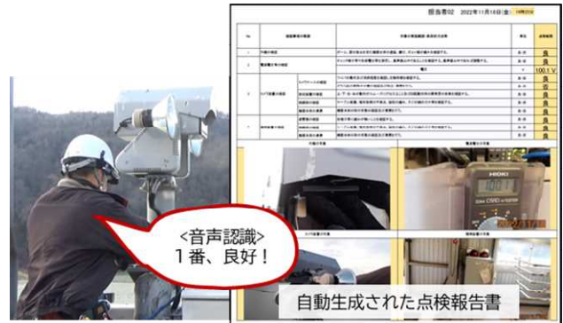
図4 スマートグラスを活用した電気通信設備点検
