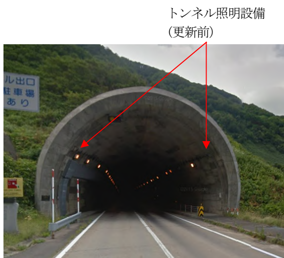
写真-1 西の河原トンネル (国道229号、KP 55.1)
