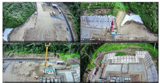
写真-8 運搬物画像カメラ撮影状況
