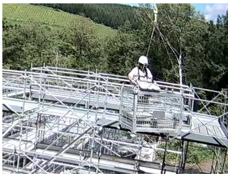
写真-9 鋼製ボックスを活用した資材運搬例
