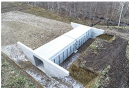
写真-3 完成したRCボックスカルバート
