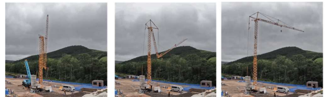
写真-5 定置式水平ジブクレーン組立状況
