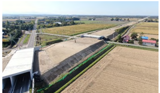
図-11 載荷盛土施工中の空撮写真
