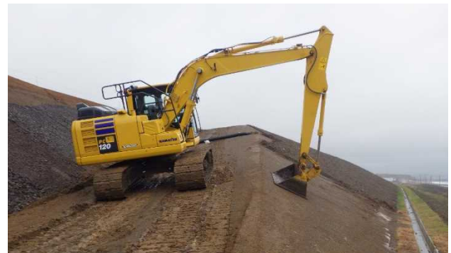
写真-9 ICT建設機械 (MG) 施工状況
