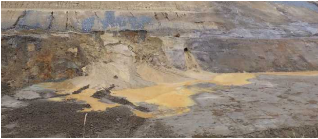
写真-4 湧水状況写真
