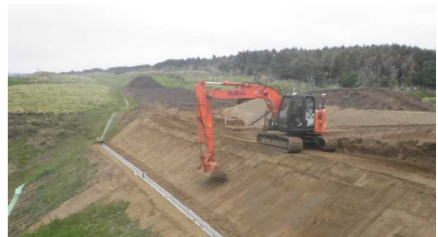
写真-7 ICT建設機械 (MC) 施工状況
