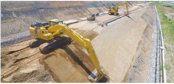
写真-3 知来別改良施工状況
