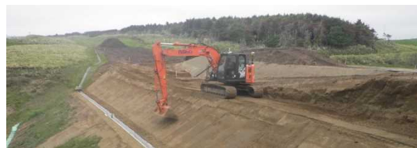
写真-2 知来別中央改良施工状況
