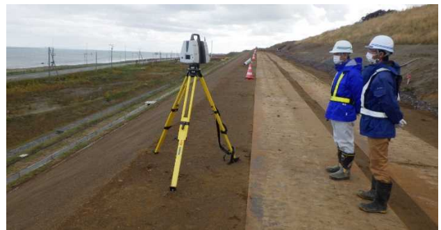
写真-6 TLSによる測量状況
