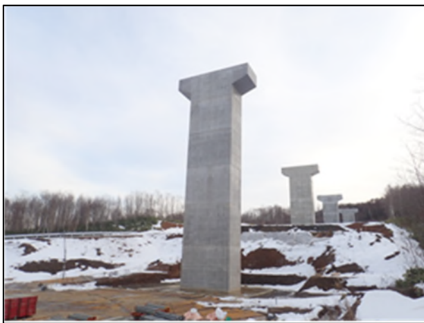
図-2 銀山大橋 P5 橋脚
