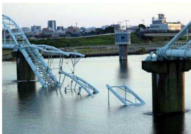
写真-2 六十谷水管橋の崩落状況 2) (2021年10月3日撮影)
