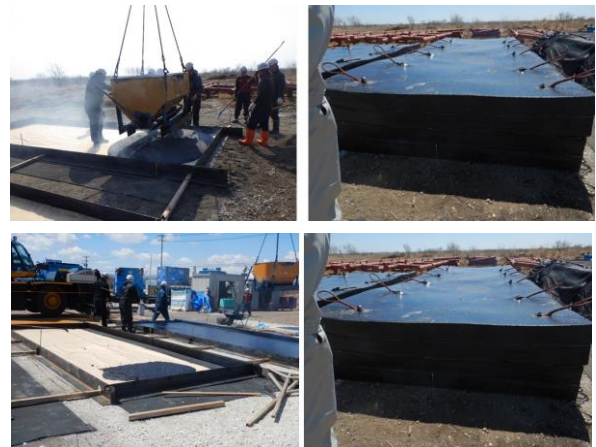
写真-5 アスファルトマット現地製作状況
