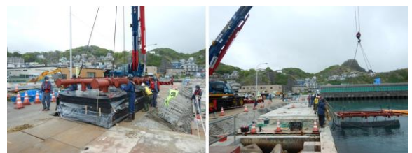
写真-6 アスファルトマット現地据付状況
