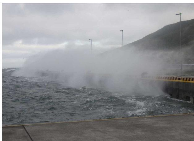
写真-1 耐震岸壁前面水域の擾乱状況
