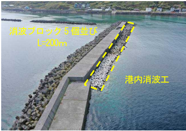
写真-2 南外防波堤 港内消波工設置状況
