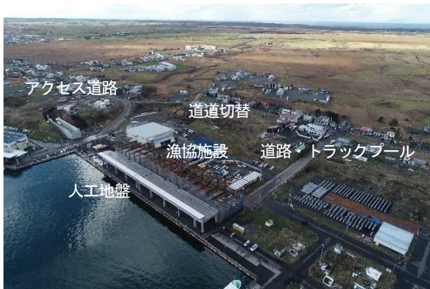
写真-4 工事輻輳状況
