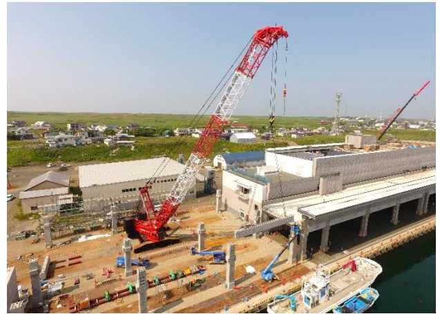
写真-3 プレキャスト部材設置状況
