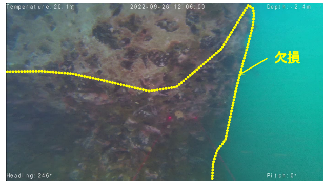
写真4 4.5m岸壁(スパン64、水深2.4m付近)
