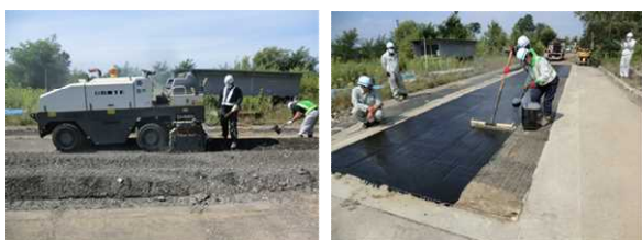
(a) 既存舗装の切削 (b) 防水材の塗布 写真-2 屋外防水工ヤードの製作状況
