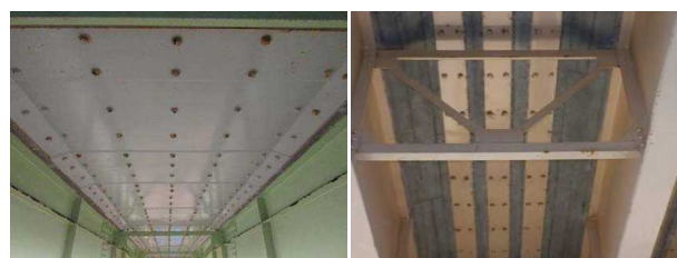
(a) 全面貼り (b) 短冊状 写真-1 鋼板接着補強の例
