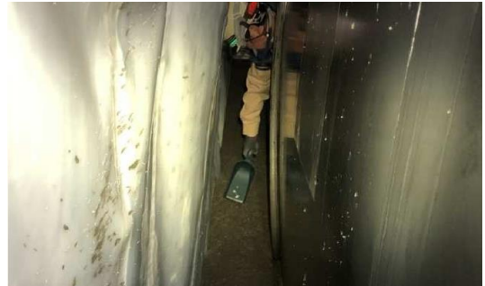
写真-2 セントル内部の採取状況
